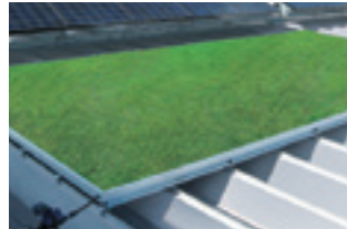
⑨ 完成→施工後灌水
