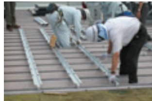
③ ネット受け金具取付け
