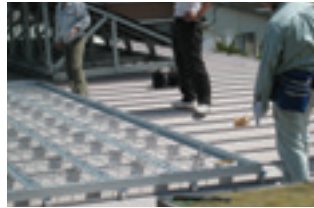
⑤ 縁材取付け
