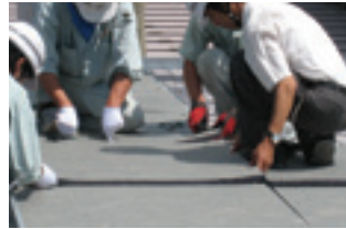
⑥ 植栽基盤敷込み
