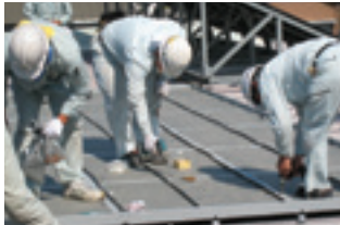
⑦ 目地テープ貼り 灌水チューブ取付け
