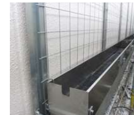
排水マットを敷き込み
