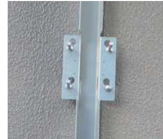
緑化パネル 固定ボルト取り付け
