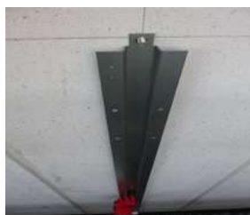
アンカーボルトに 受け金具をセット
