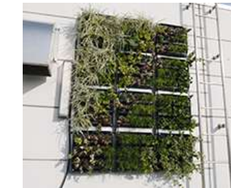
壁面緑化の完成
