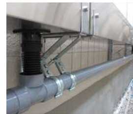
排水管を取り付け
