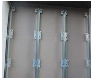
ベース金具の設置
