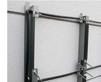
灌水チューブの設置 通水確認
