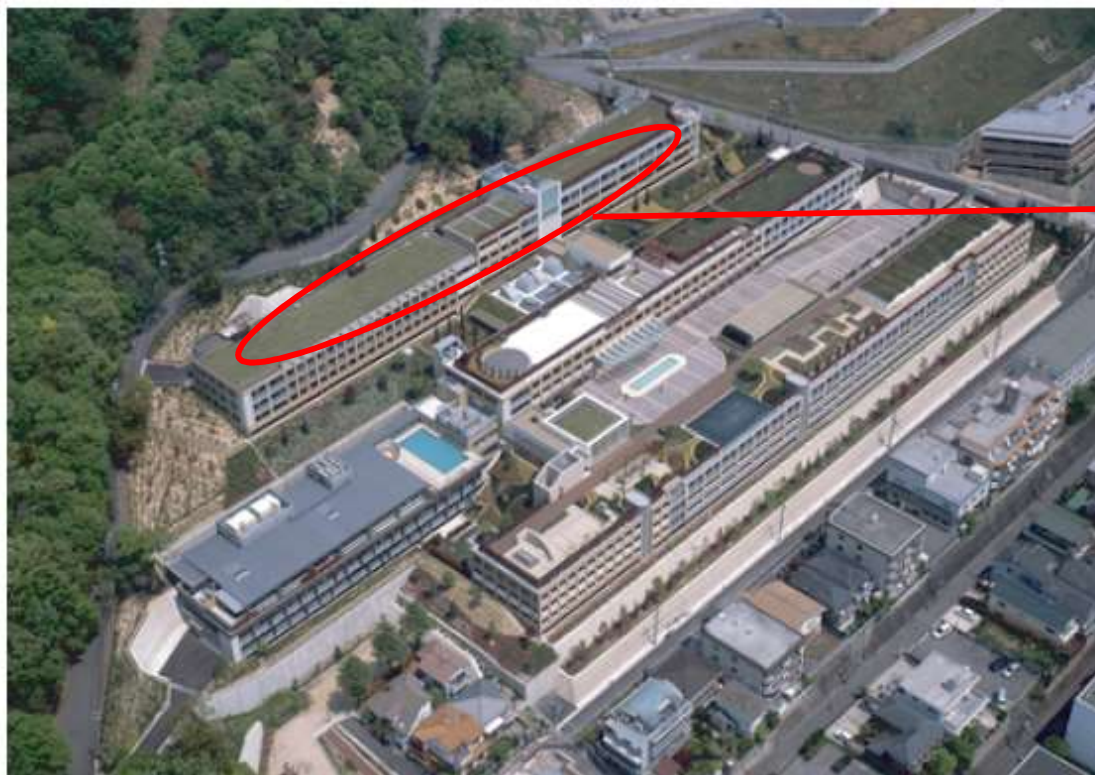
高齢者専用賃貸住宅（兵庫県神戸市）
