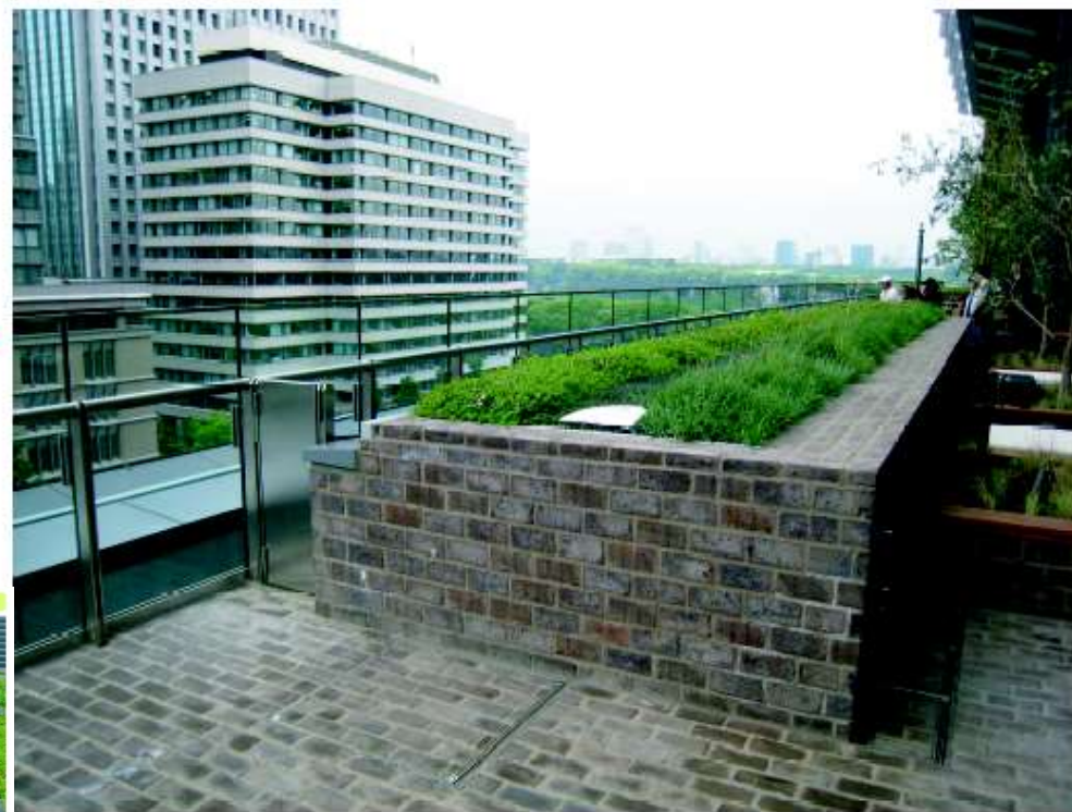
7階テラスEGM使用部分
