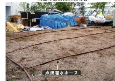
点滴灌水ホースの設置
