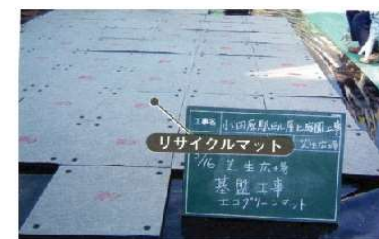
芝生用植栽基盤「エコグリーンマット」の施工
