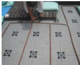
灌水ホース敷設
