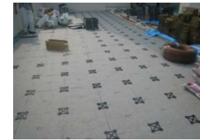
エコグリーンマット 敷設・ジョイント
