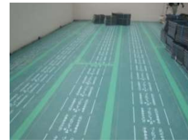
耐根シート敷設
