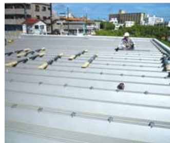
墨出し・ハゼ止め 金具取り付け
