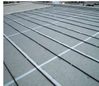
フェルト目地テープ鍼貼 り・点滴チューブ取り付け
