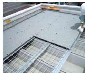
フェルト敷き込み
